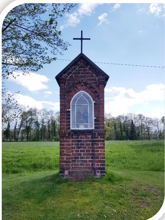
Im Plumpe 18, Westerwiehe
